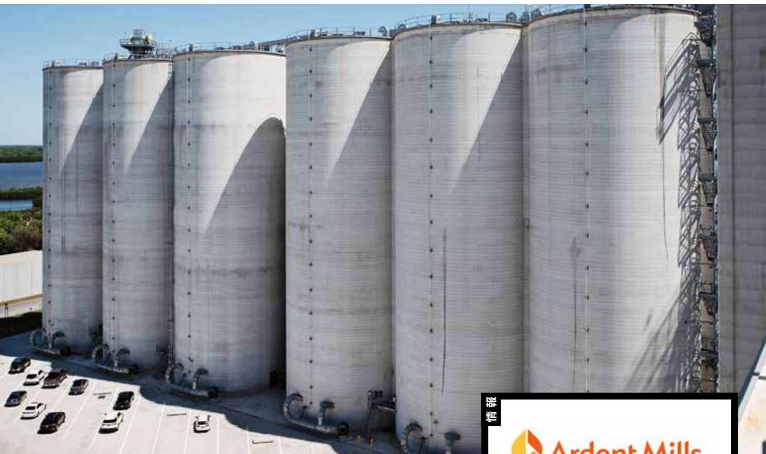
高さ160フィート（約50メートル）のサイロの総貯蔵容量は11万1,000トンです。
