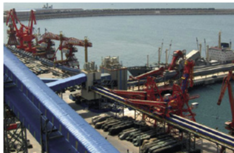
Grain Terminal Dalian Beiliang, China. Effiziente und moderne Hafenanlage mit 2 Bühler Schiffsbeladern Portaload (2×1000 t/h) und 2 Bühler Schiffsentladern Portalink (2×1000 t/h) sowie Bandförderanlagen.
