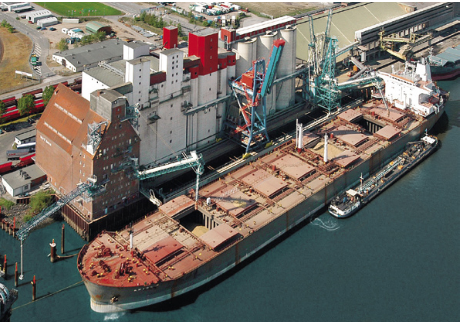
Siloanlage P. Kruse in Hamburg, Deutschland.
