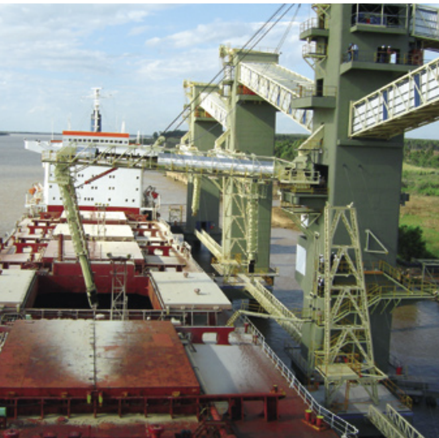
Bunge S.A., Ramallo – Buenos Aires, Argentinien. 2 Beladelinien mit Durchsätzen von je 1600 t/h, 4 Beladetürme.
