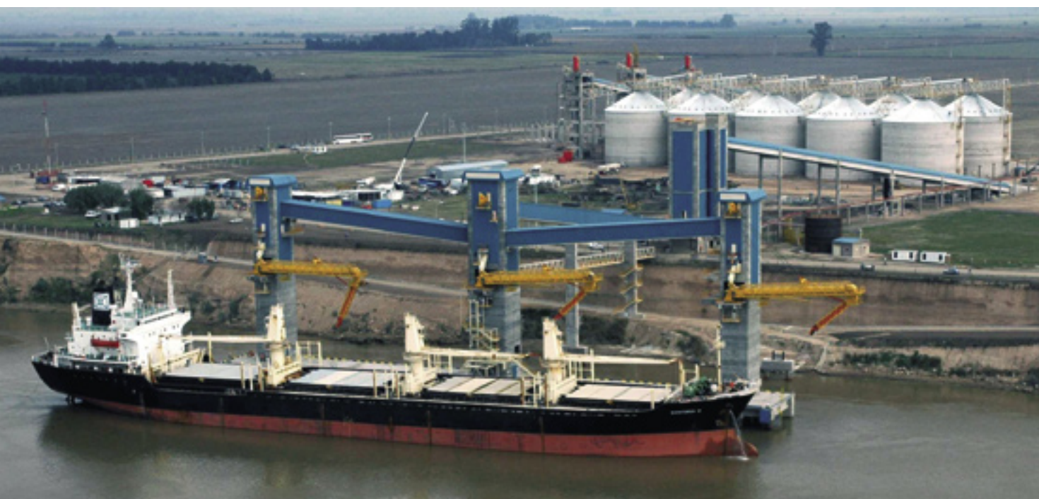
Noble Argentina S.A. – Río Paraná, Argentinien. 3 Beladetürme, 2 Beladelinien mit Durchsätzen von je 1600 t/h Soja.
